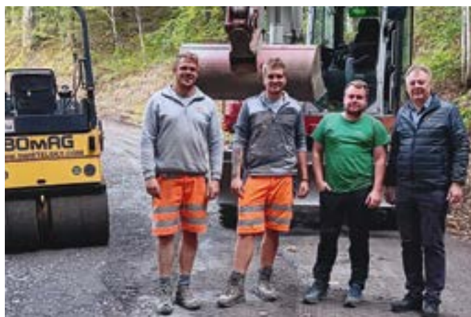
Sanierung der Schlanitzer Straße.
