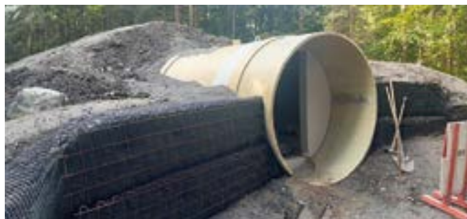
Neuer Hochbehälter in Paßriach wird errichtet.
