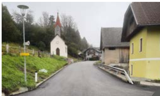
Baustelle L 25 in Mellach
